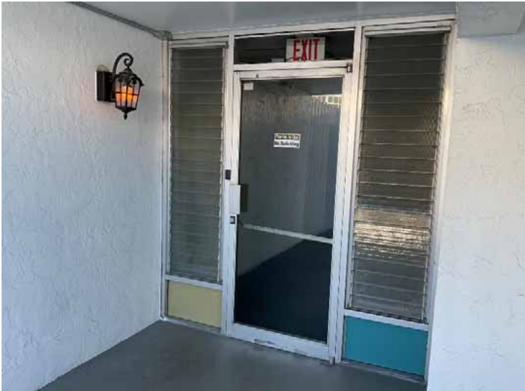
Bldg A Windows & Door - Hallway Entrance
