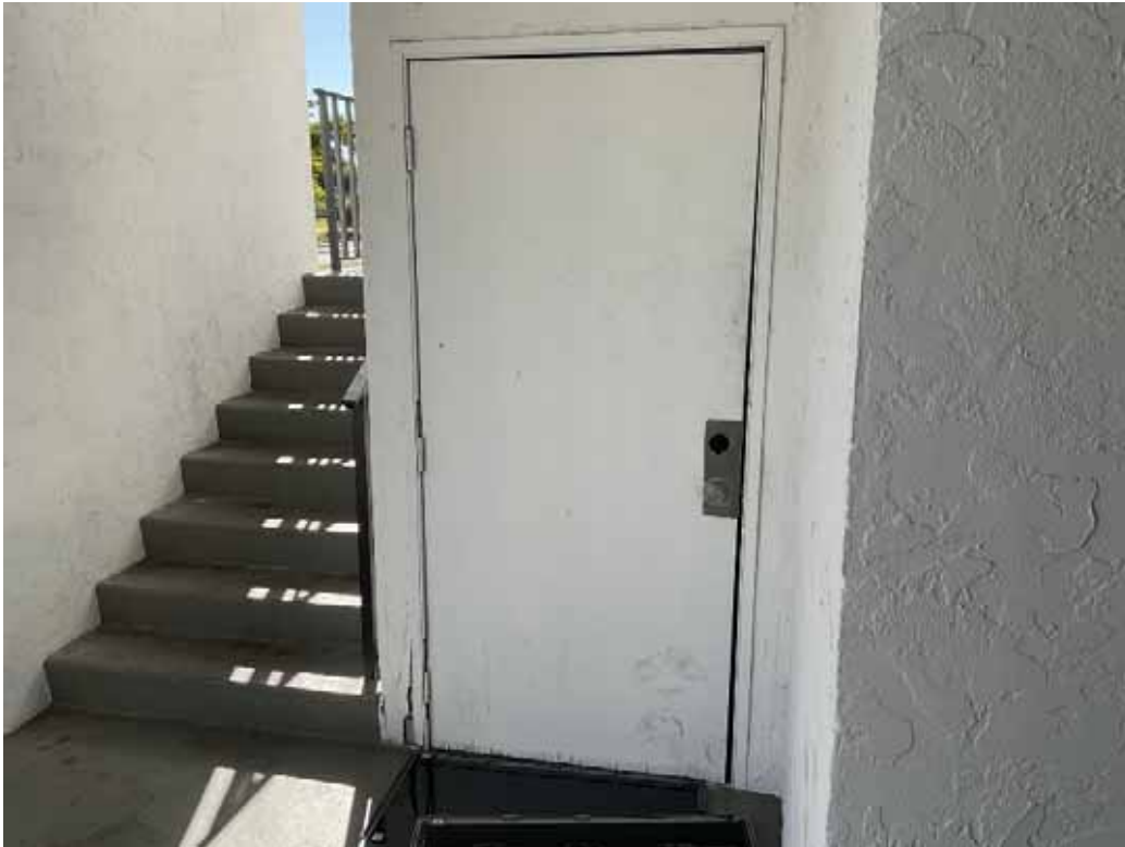
Bldg B Stairway Storage Door
