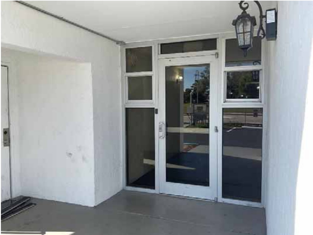
Bldg B Windows & Door - Hallway Entrance
