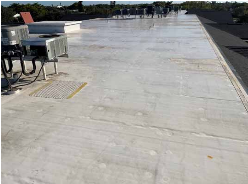
Bldg B Roof
