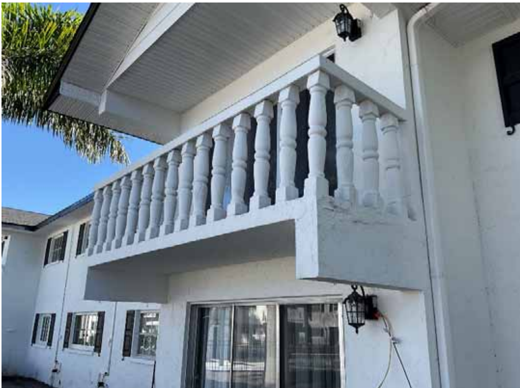
Bldg A Balcony
