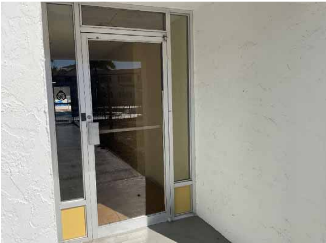
Bldg B Windows & Door - Hallway Entrance
