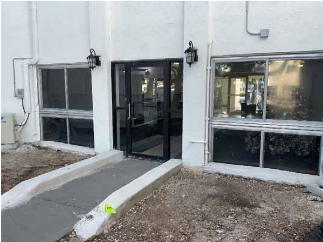
Bldg A Windows & Door - Lobby
