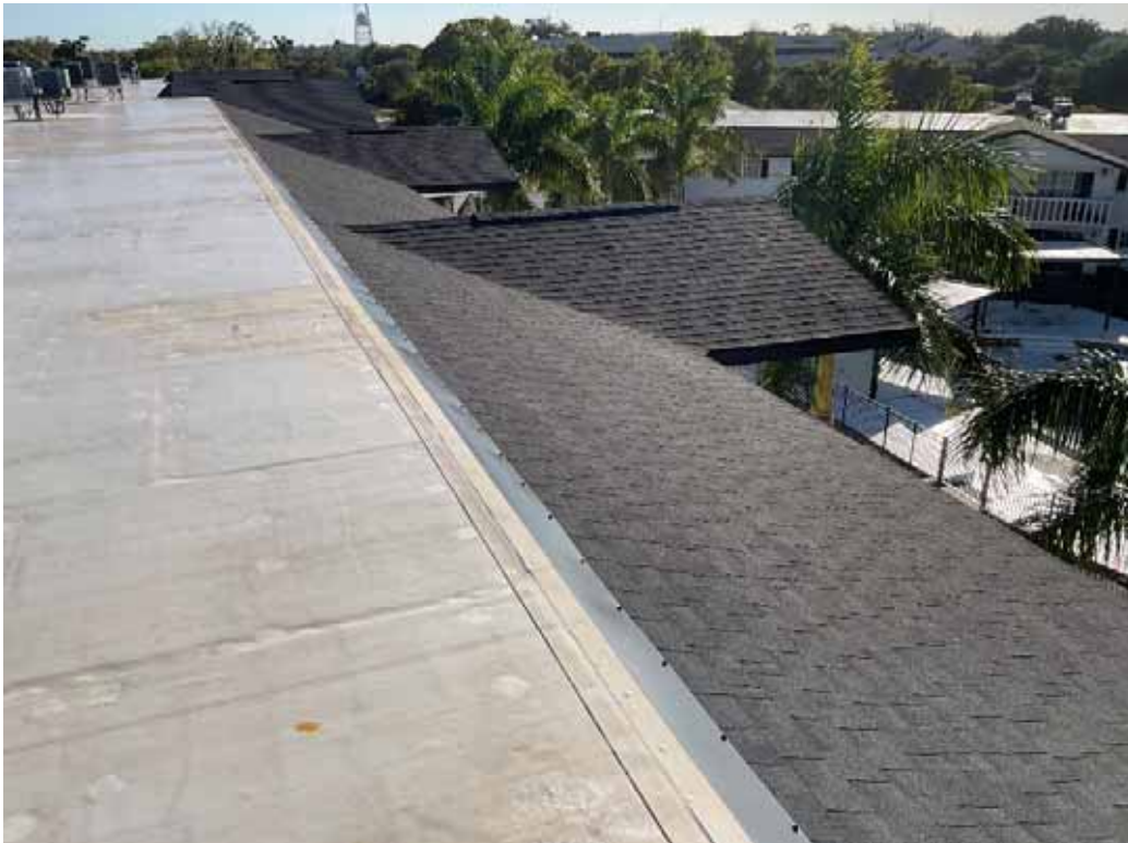
Bldg B Roof
