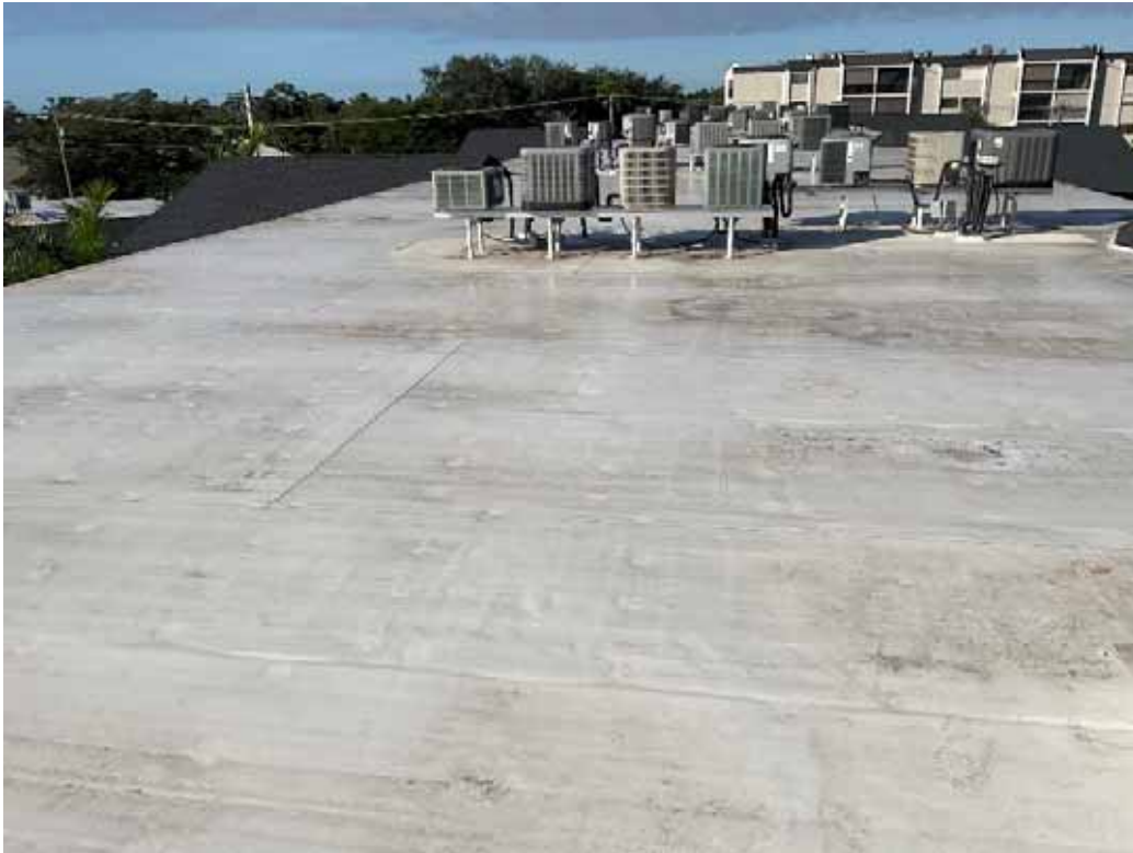
Bldg B Roof
